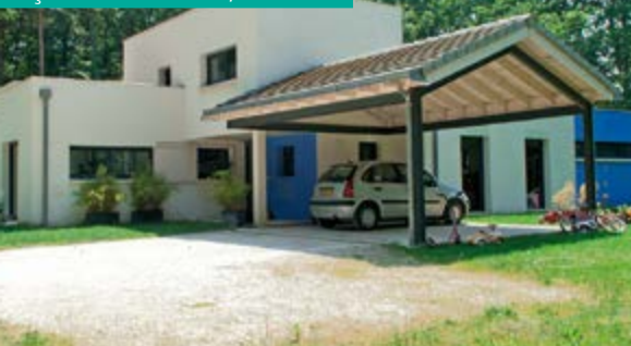
Façade d'entrée au Nord, abri voiture
