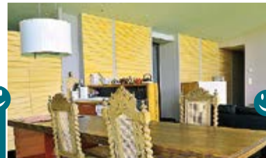
Placards constituant un espace tampon côté Nord
