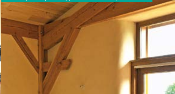
Structure poteau-poutre apparente et murs en paille arrondis
