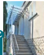
Pergola côté entrée
