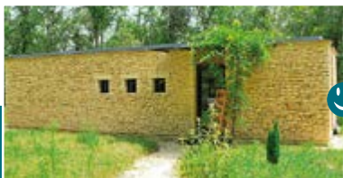
Surface faiblement vitrée au Nord
