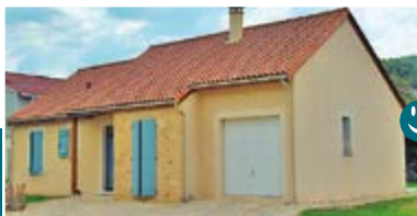
Espace tampon du garage
