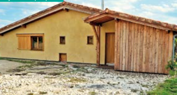
Façade Nord peu percée
