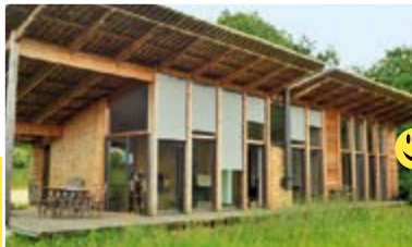
Protection solaire en façade Sud
