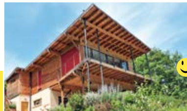
Débords de toit
